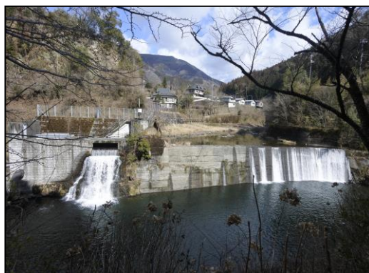
小水力発電所
