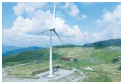
完成した新風車(3号機)
