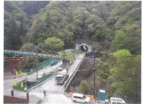
整備中の町道佐渡鷹取線
