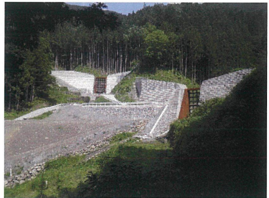
溪流に設置された透過型砂防堰堤
