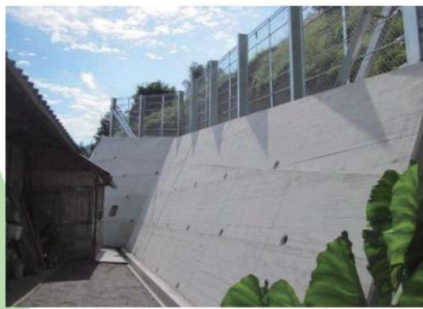
がけ崩れ対策
