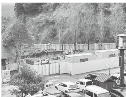
太郎川で建設が進む木質バイオマス発電所
