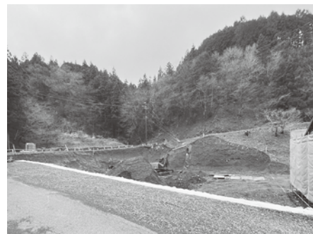
大越ペレット工場増設予定地の敷地
