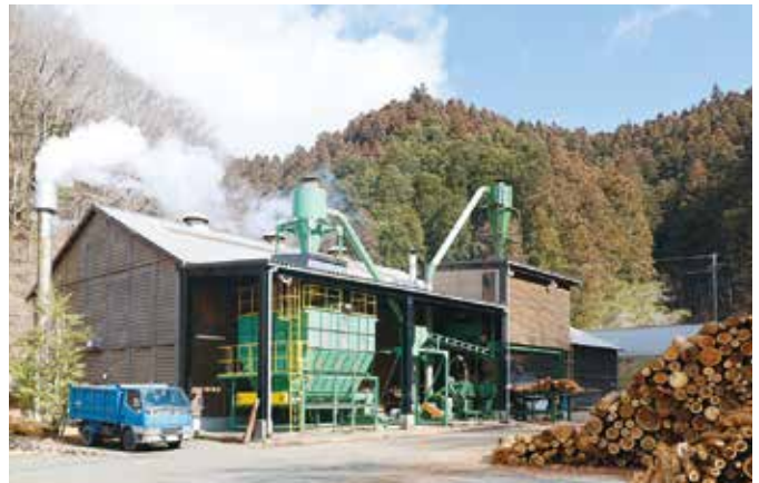
増設を予定している木質ペレット工場(広野)
