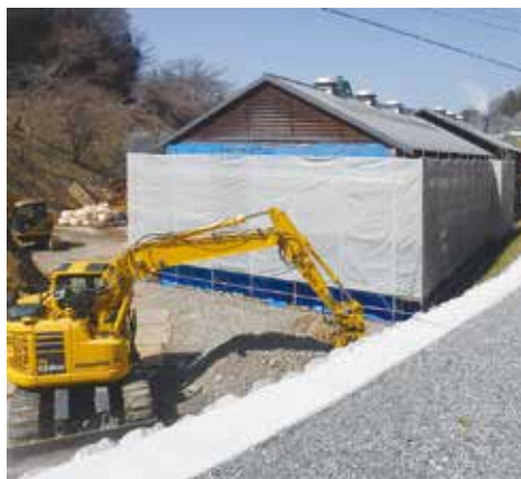
既存ペレット製造施設の改修工事
