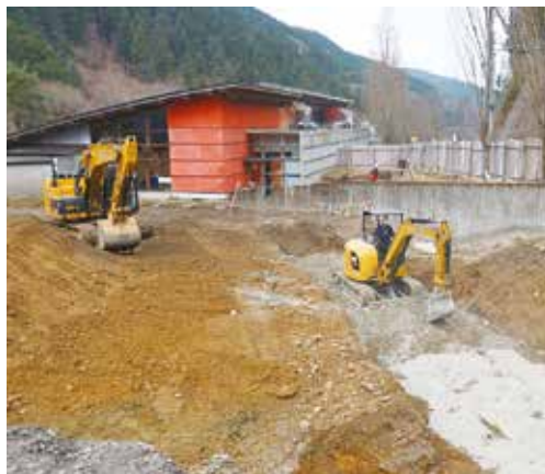
発電所建設地 敷地整備作業
