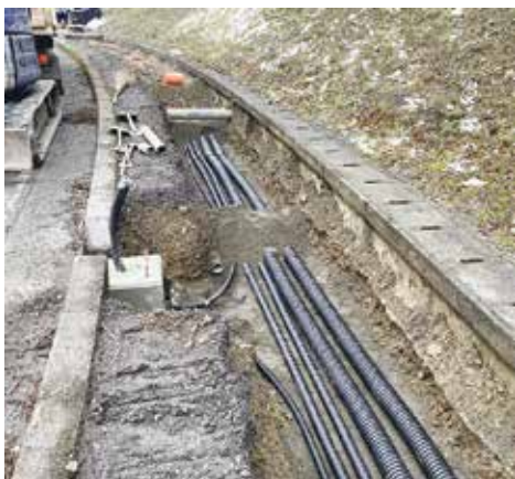
専用線埋設のための配管作業
