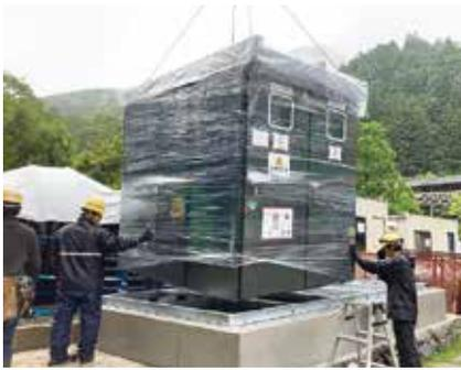
受変電設備の設置作業の様子
