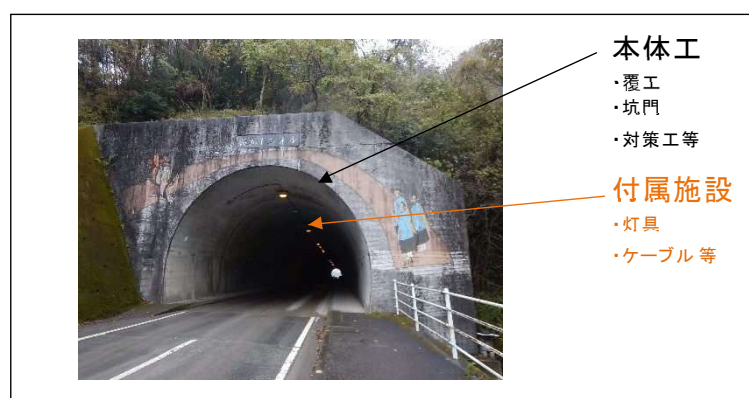
図 1.2 トンネル構造
