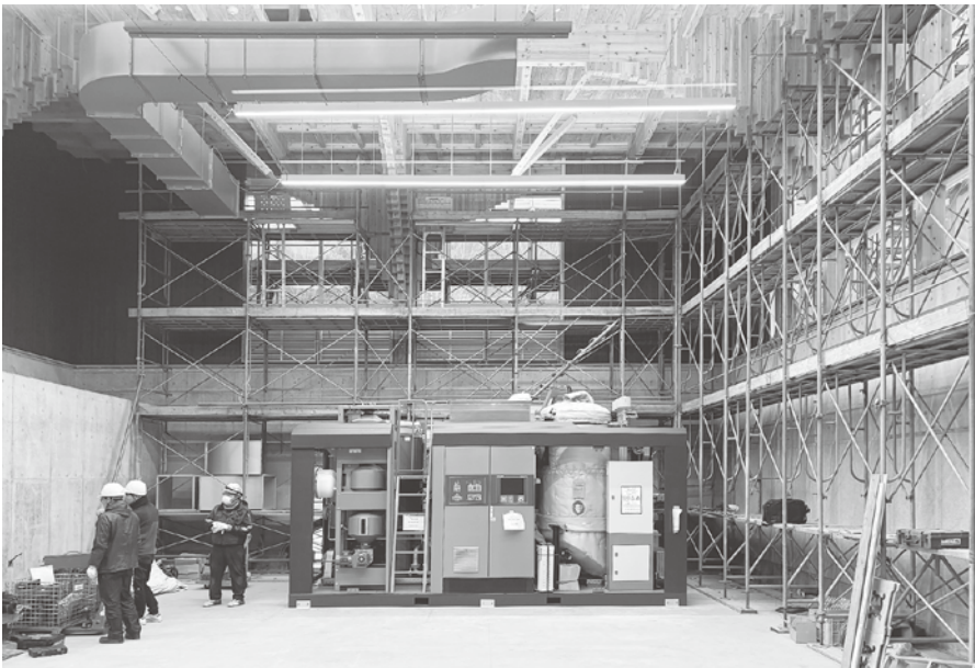
完成間近の木質バイオマス発電所建屋内に搬入される発電機等の様子
