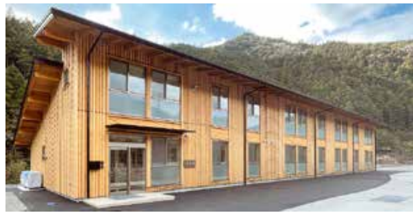
完成した2号棟
