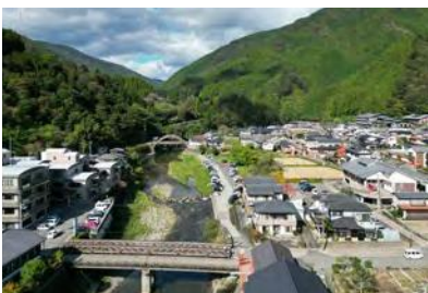
梶原川と木造橋
