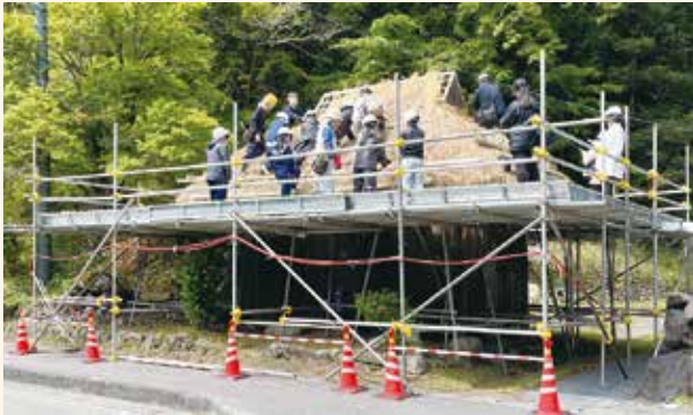
足場の上で元気に作業中
