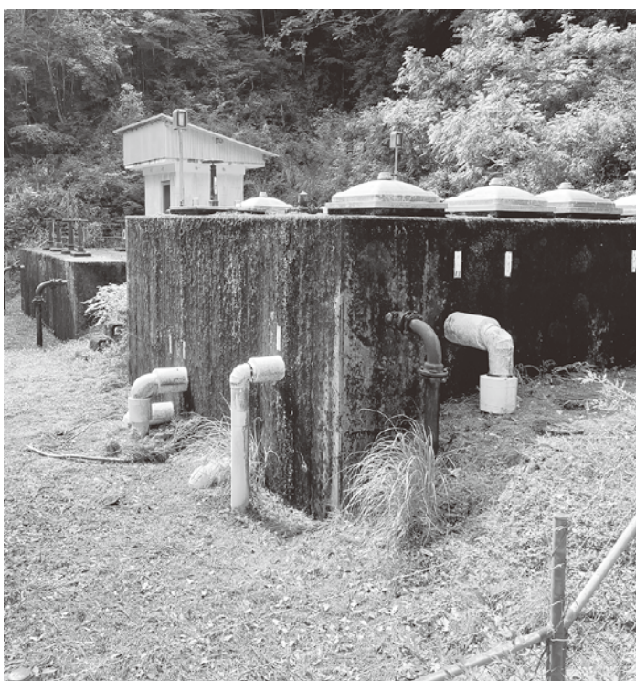
町内の水道施設の一つである松原簡易水道浄水場
