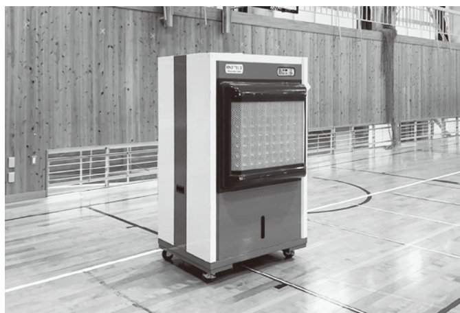
梶原学園体育館に設置された気化式冷風機
