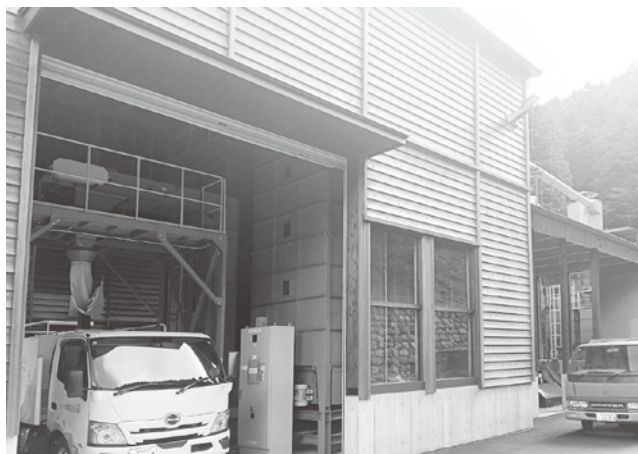
11月中旬から機械入替、配線等工事及び12月初旬から試運転を実施する木質ペレット工場(広野)
